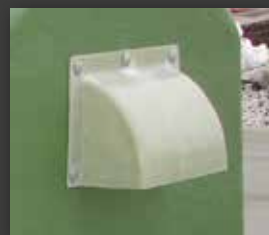
Ventilation arrière protégée (évite les courants d'air et que l'eau de pluie rentre)
